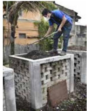
diberi lubang udara berukuran 10 cm x 10 cm. Lubang udara ini berfungsi sebagai sirkulasi oksigen agar mempermudah proses penguraian mikro organisme secara alami.
